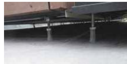
12 部材接合箇所
