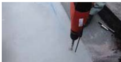
① 防水施工後、墨出し作業
