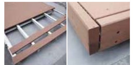
⑨ ウッドデッキ敷設・固定
