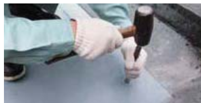
② 金属系アンカー打込み
