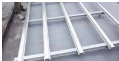
⑧ 大引・根太 取付け
