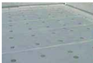
▲IHディスク鋼板の取り付け
